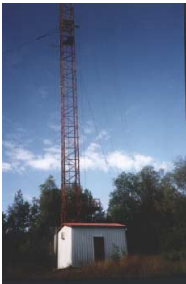
Bunnseksjon og tilhørende bygning for den sørlige masta ved Askøy Kringkaster. I de senere år har masta blant annet vært benyttet til et par lokalradiosendere på FM.
